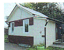
Общий вид здания, Рис. 5
