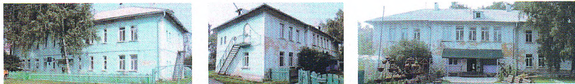
Общий вид здания, Рис. 1
