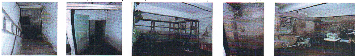
Фрагменты помещений подвала, Рис. 2
